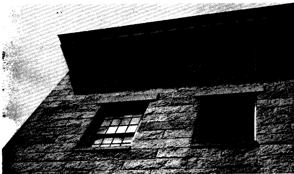
215. Casa de la comunidad shaker, Concord, Vermont, 1832. Una muestra de la excelente fábrica de piedra realizada por esta secta religiosa.
