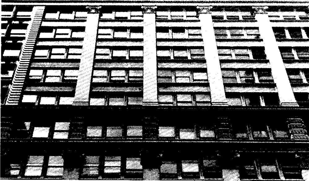
227. William Le Baron Jenney, edificio The Fair, Chicago, 1891. En este proyecto se hace del esqueleto el factor determinante.
